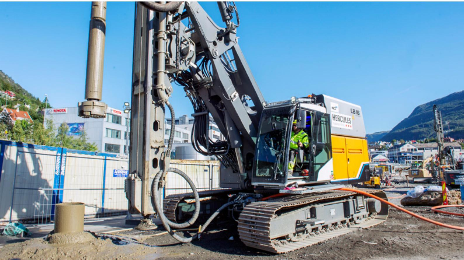
Vestland fylkeskommune har til saman 17 elektriske arbeidsmaskiner. Verdas første og einaste batteridrevne borerigg starta i haust arbeidet med bybanetraseen til Fyllingsdalen. Foto: Marit Hommedal.
