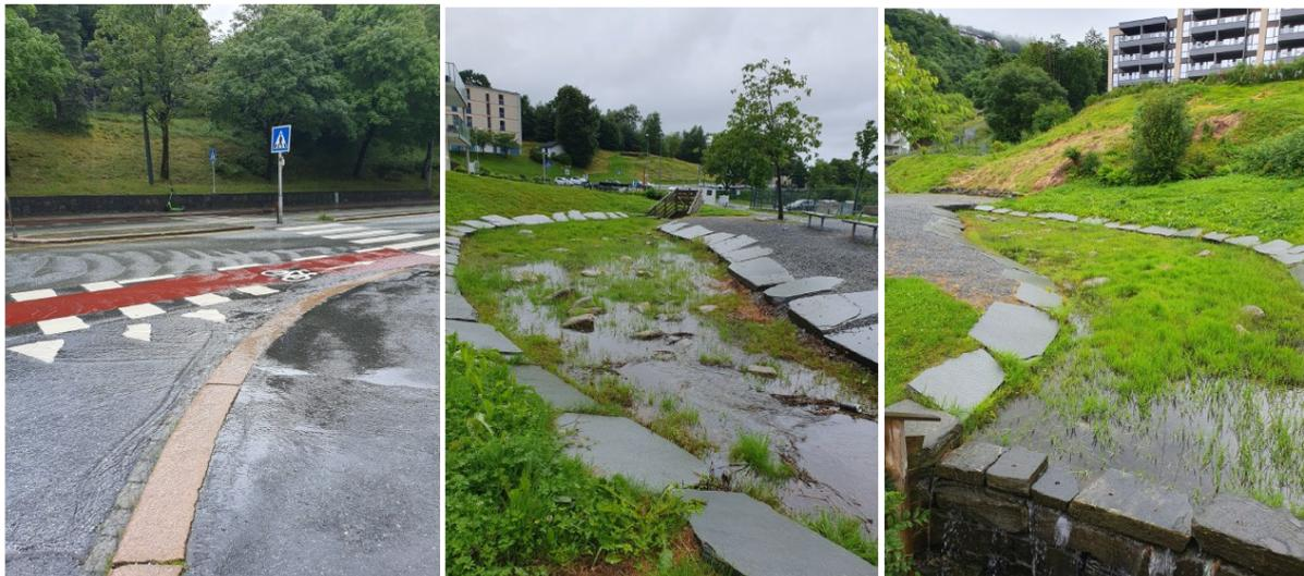
Handtering av overvatn. Til venstre: Vanleg overvasshandtering i Natlandsvegen, Bergen kommune, med avrenning til OV-leidning. Til høgre: Fordrøyingsanlegg ved Slettebakken. Gjenopning av bekker og flater som kan infiltrere og redusere avrenning av overflatevatn er døme på tiltak for klimatilpassing. På Slettebakken i Bergen har ein utvikla slike naturbaserte løysningar for handtering av overvatn. Foto: Vegard Eriksen
