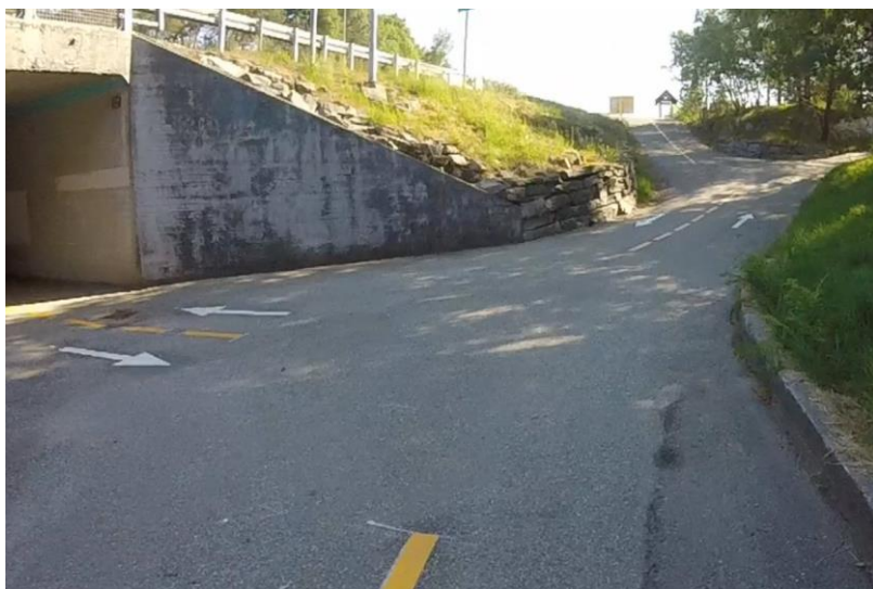
Figur 7-2: Døme på oppmerking som viser at det er tenkt sykling i to retningar på eit gang- og sykkelveg-anlegg. Bilete 23
