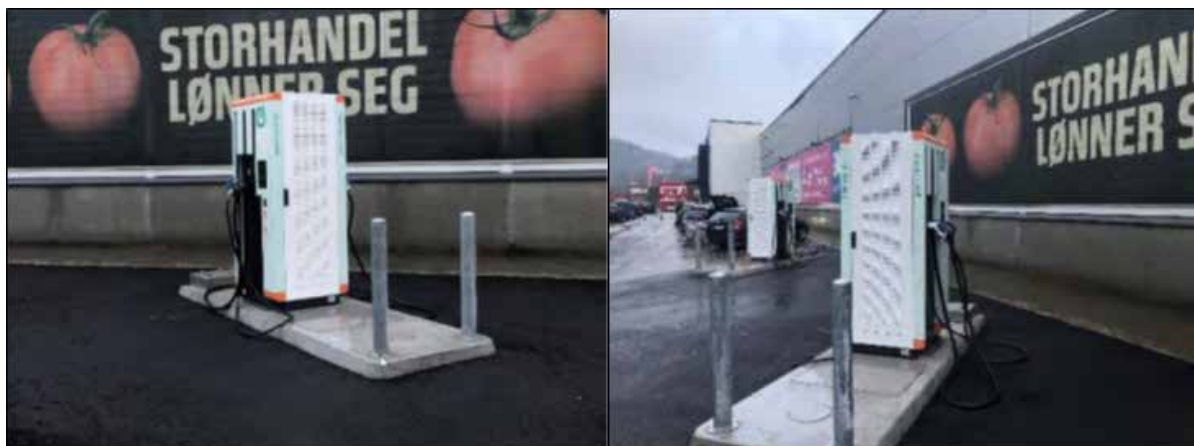
Figur 4: Grøn kontakt (Fabrikat Delta), Lyngdal, Ladar inkludert i kontakt. kontakt på begge sider (CCS og CHAdeMo) Foto: Erlend Lachmann
