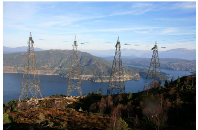
Kraftlinje høgspent 300 kV. Foto: Sølve Dag Sondbø/Vestland fylkeskommune.
