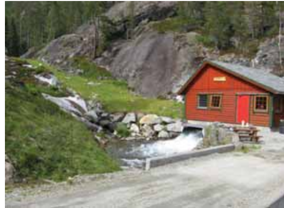
Austdøla kraftverk i Odda med kraftstasjon og nedgraven røyrgate. Foto under viser inntaksdammen. (Foto: Kompas as)
