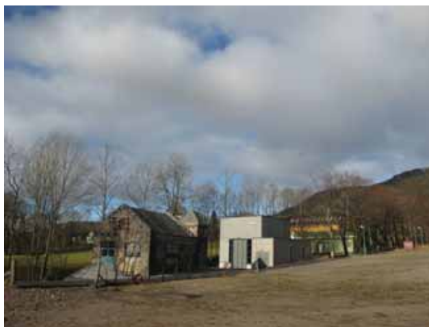
Valen kraftverk Kvinnherad. Kraftstasjon frå tre epokar, 1910, 1939 og 2008. (Foto:Ove Tvedt)
