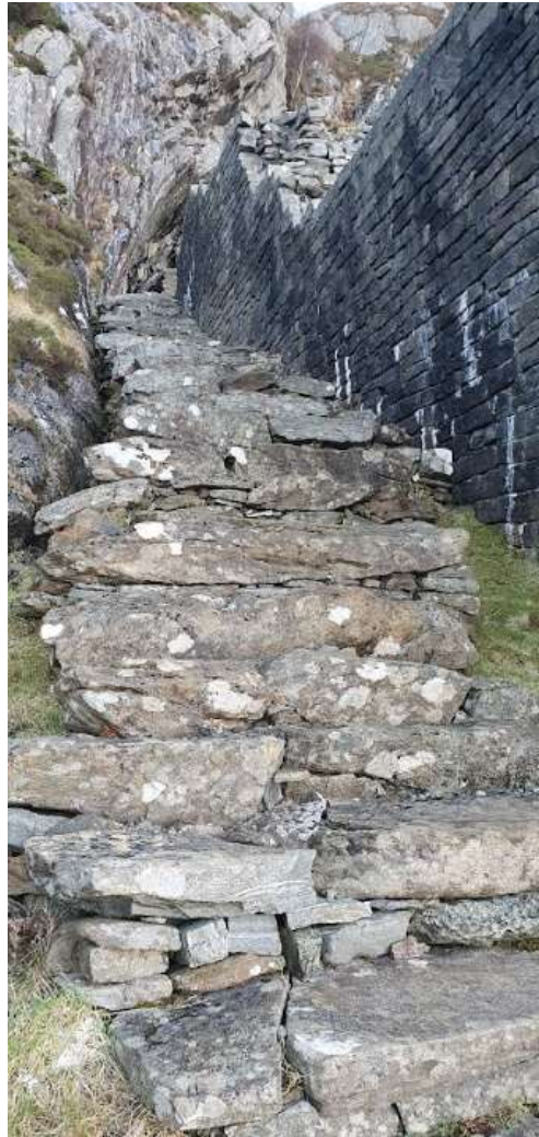
Trappene opp til Sunnivakyrkja ved terrasseveggen. Det renn ein bekk mellom berget og trappa til venstre i biletet. Denne bekken må reinskast opp i årleg slik at han renn fritt.
