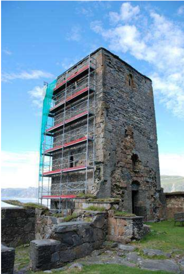
Frå restaureringsarbeidet av tårnet mot sør i 2008. Foto: Bakken&Magnussen A/S
