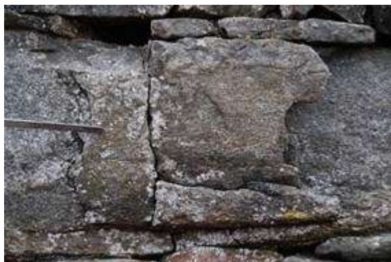
Fuging 2007 på utvendig tårn før og etter for å unngå «vassfeller».
