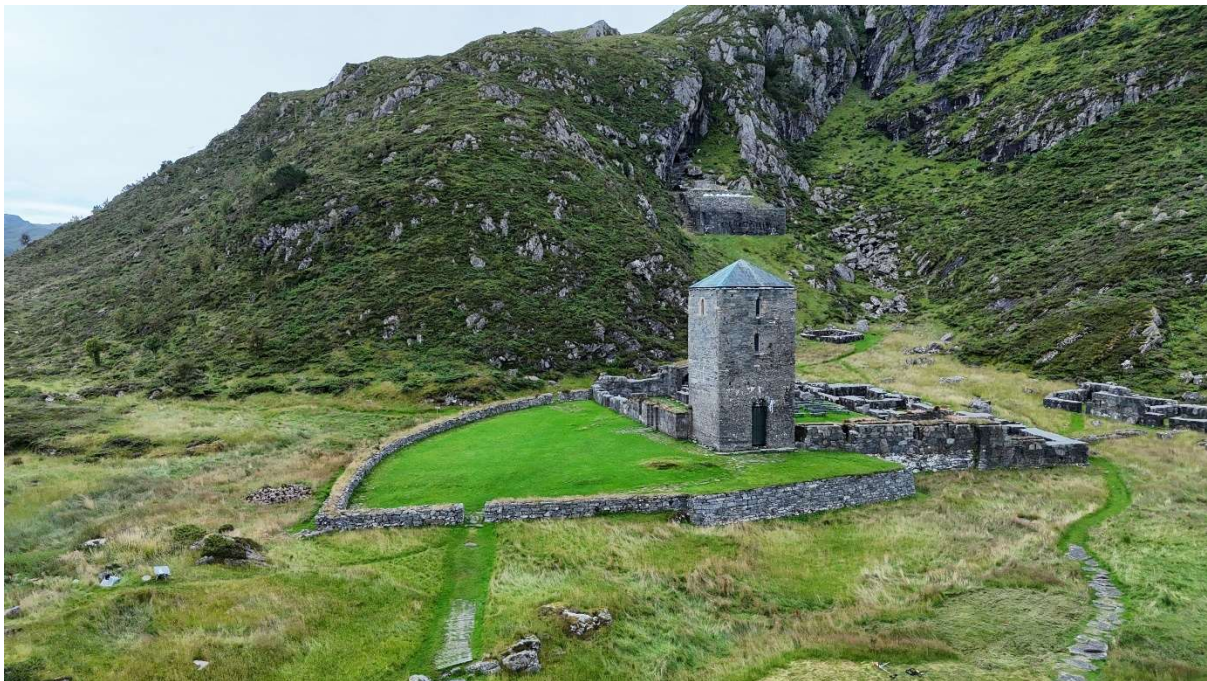
1 Selja kloster 12.08.2025. Kvite sekkar med steinheller oppe ved terrassane og Sunnivahola, indikerer at ruinprosjektet ikkje er heilt ferdig. Arbeidet på ruinane til Sunnivakyrkja skal halde fram til 2027. Foto: VLFK/Ragnhild Egeland Torp
