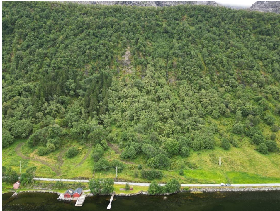
Figur 9: I fjellsiden ses bart fjell som kan tolkes til å være tidligere utglidninger av vegetasjonsdekke/løsmasser, og langs vegen er det etablert tørrmur der det har blitt lagt veg gjennom løsmasser som mulig kan være jordskredavsetninger. Bildet viser området like vest for nytt påhugg.
