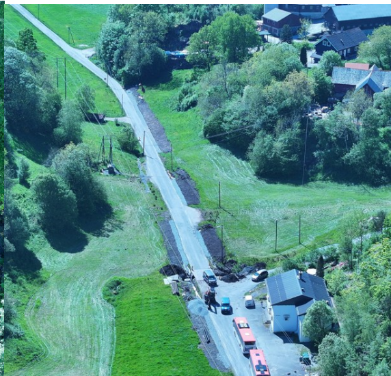
Bilete 12: nye drensgrøfter, stikkrenner og kummer
