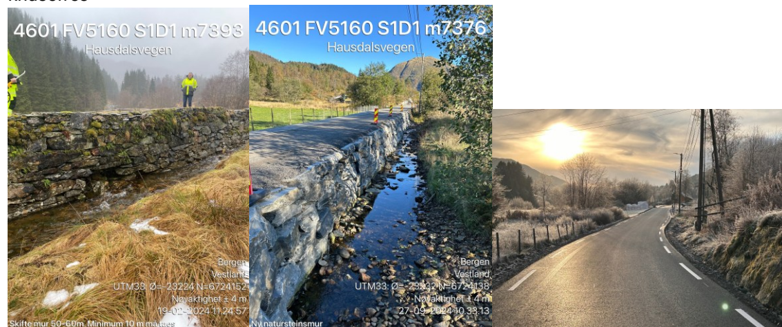
Bilete 6 og 7: natursteinmur f r og etter utbetring
